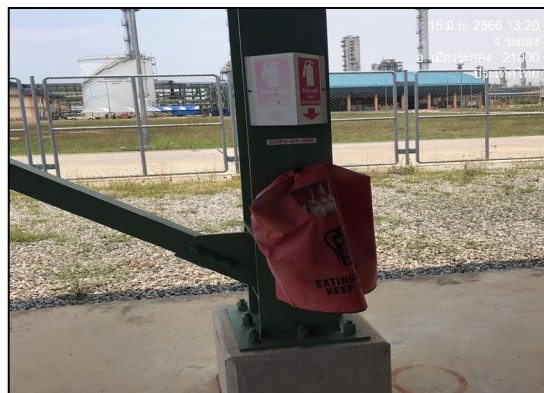
ติดตั้งเครื่องดับเพลิงแบบเคมีผงที่บริเวณสถานีวัดและควบคุมแรงดันก๊าซ (MRS)
